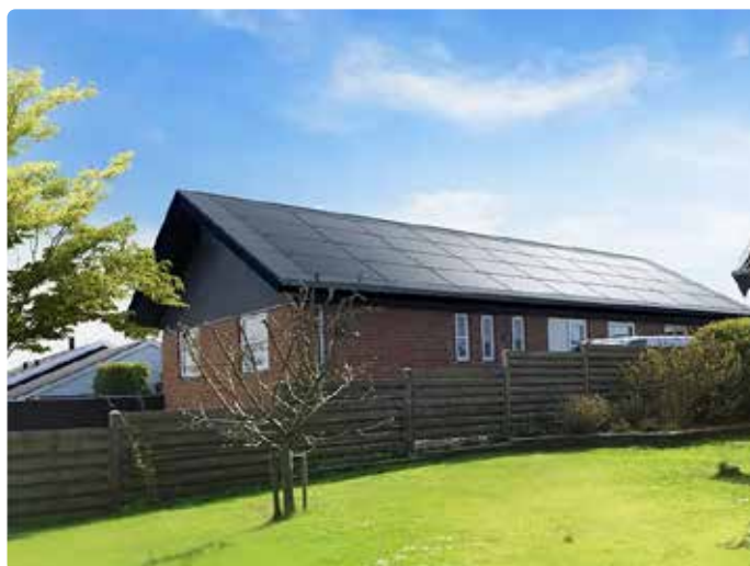
Energipanelerne, der både producerer el og varme er integreret i parcelhusets tag.
